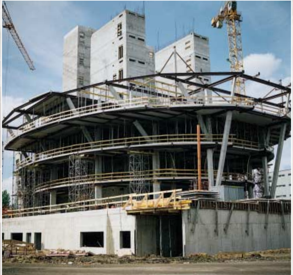
2. Montage der Stahlkonstruktion im 3. OG; im Hintergrund die vorab in Kletterschalung hergestellten Treppenhäustürme
